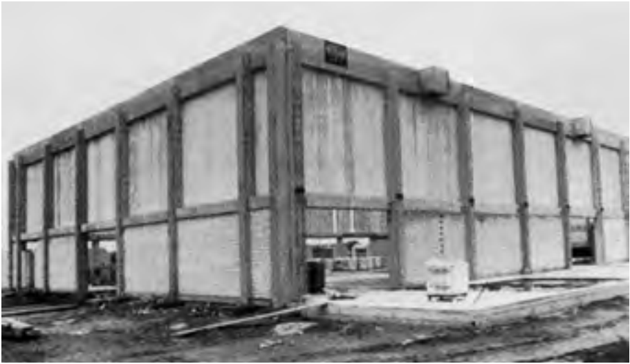
Die neue Turnhalle des Turnvereins steht in ihrem Rahmen
